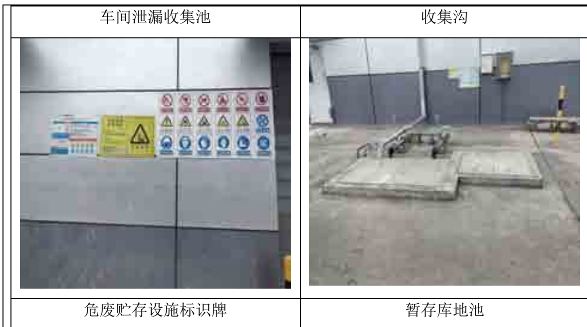
图 3.4-1 危废暂存库现状照片
